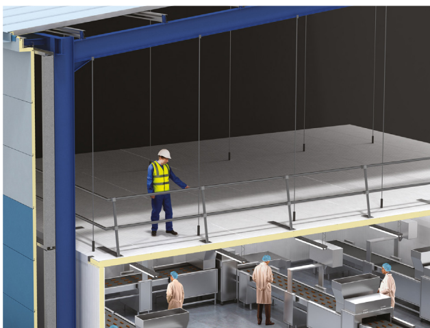
Rys. 14. Zabezpieczenie podczas montażu.
