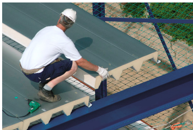
Rys. 16. Montażysta zabezpieczony pasami bezpieczeństwa.
