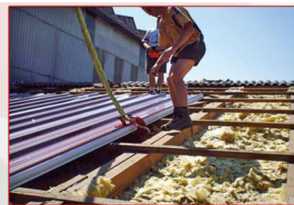
Rys. 25. Samozaciskowe narzędzie montażowe stosowane do płyty dachowej.
