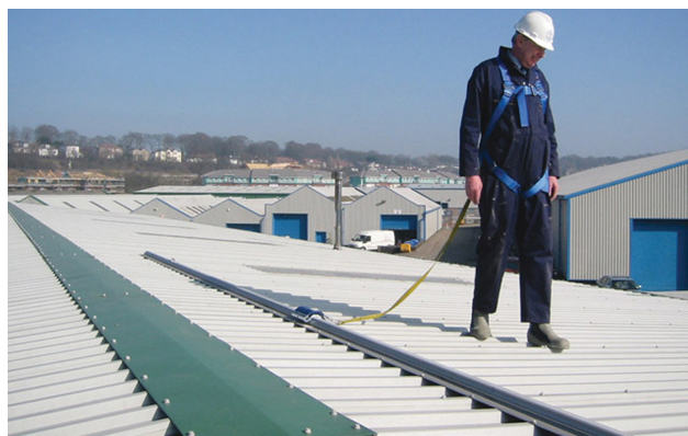
Rys. 16. Montażysta zabezpieczony pasami bezpieczeństwa.
