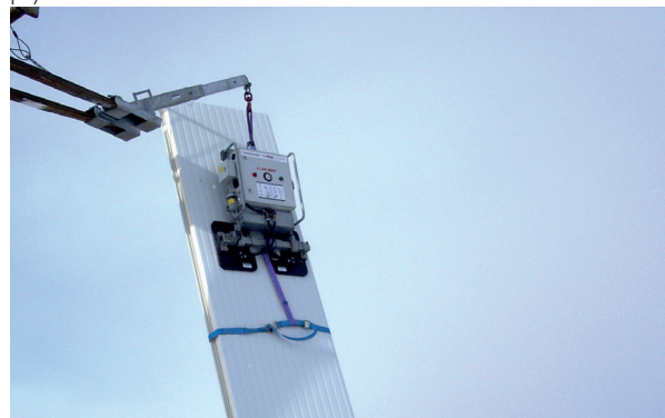
Rys. 20. Ponoszenie prawidłowo zabezpieczanej płyty przyssawkami i pasami.
