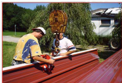
Rys. 26. Etapy transportu płyty dachowej za pomocą samozaciskowego narzędzia montażowego.
