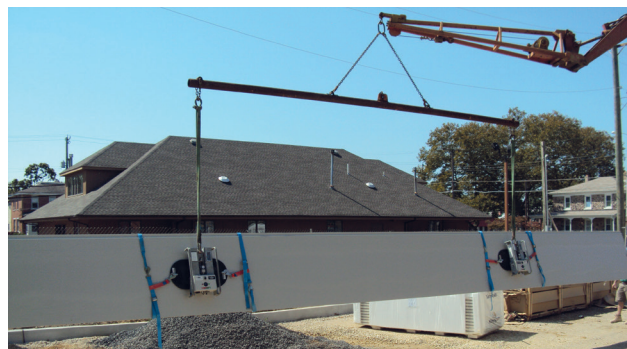
Rys. 23. Prawidłowo zabezpieczona płyta warstwowa do dalszego montażu.
