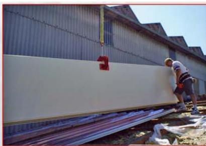
Rys. 26. Etapy transportu płyty dachowej za pomocą samozaciskowego narzędzia montażowego.
